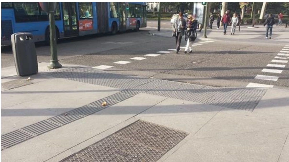
Imagen 2. Formación de vado de peatones en desnivel acera-calzada en el paseo Prado Recoletos
