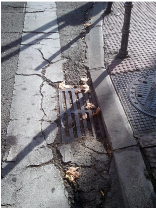
Imagen 10. Estado de conservación de un elemento de drenaje superficial que provoca, en días de lluvia, un encharcamiento en el vado de peatones
