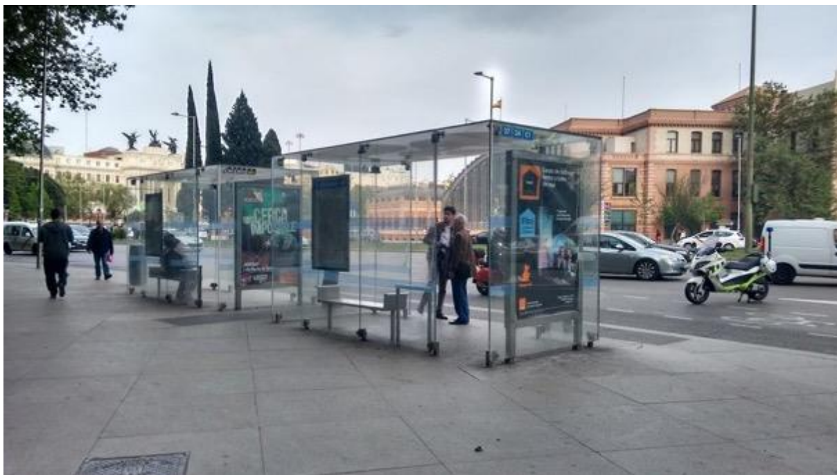
Imagen 1. Doble marquesina de acceso al transporte público. Paseo de Santa María de la Cabeza
