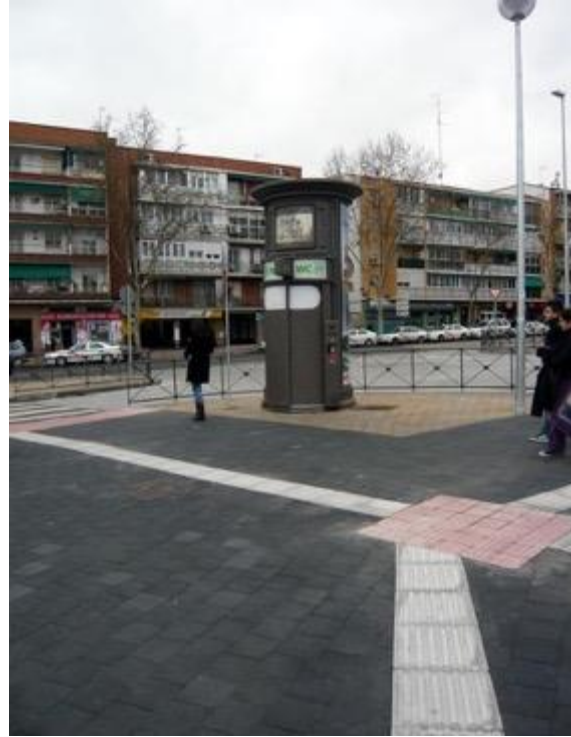
Imagen 21. Encaminamiento direccional con rosetas para indicar el cambio de dirección para transporte público, paso de peatones, etc.
