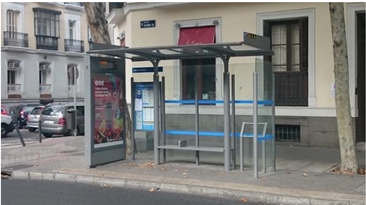
Imagen 12. Marquesina con banco, apoyo isquiático, señalización de los paneles de vidrio, etc. en la calle de Alfonso XII
