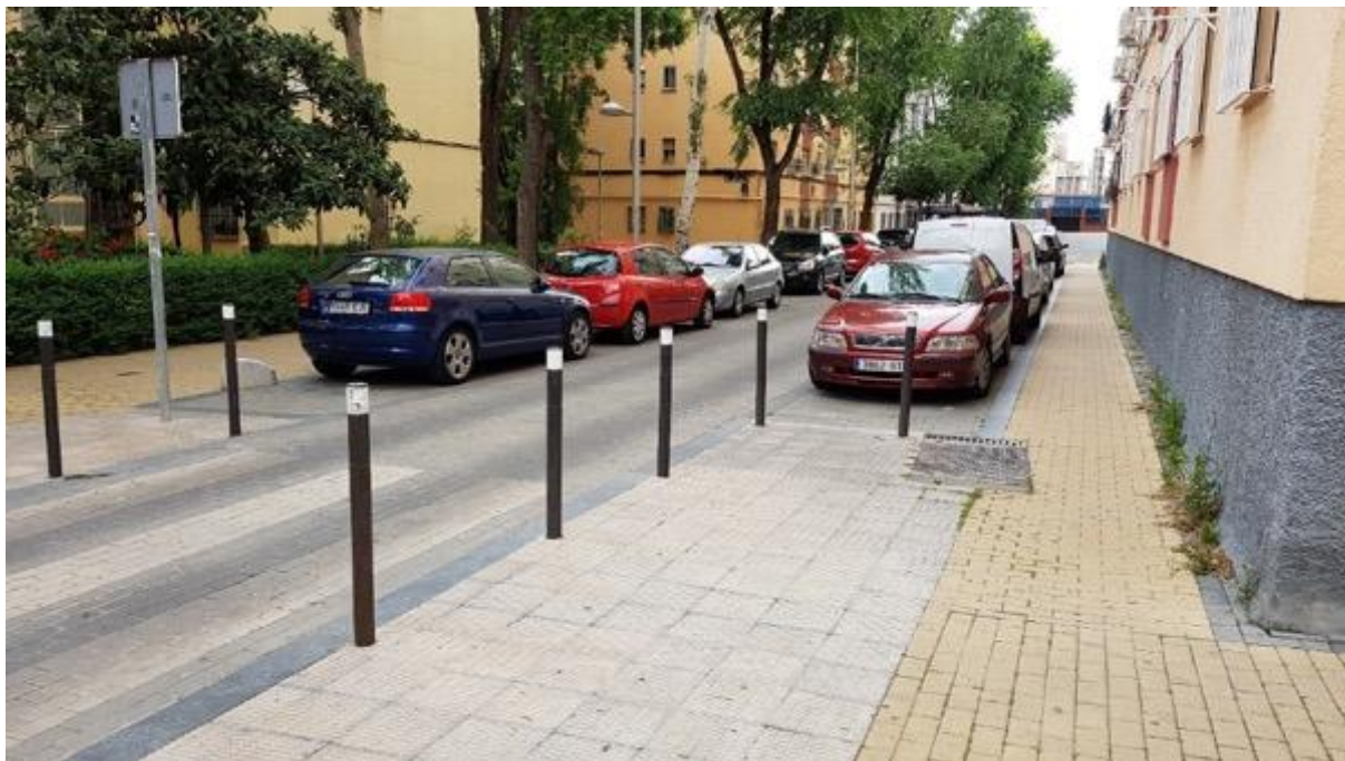
Imagen 3. Formación de vado de peatones con desnivel máximo de 4 mm entre acera y calzada
