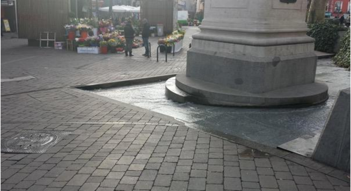
Imagen 16. Lámina de agua sin protección en la Plaza de Tirso de Molina. Deben evitarse, ya que generan peligro a cualquier viandante, pero en especial a los que presentan discapacidad visual
