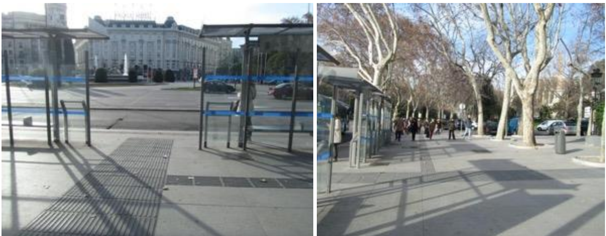
Imagen 18. Ubicación de pavimentos tacto-visual para señalar la parada de autobús y encaminamiento al paso de peatones
