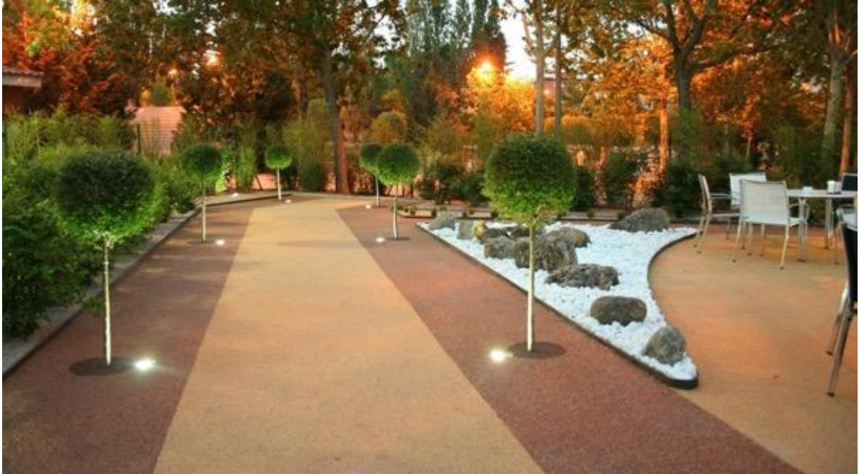
Imagen 10. Uso de pavimento drenante en los itinerarios del parque de la Paz de Fuenlabrada. En la imagen puede apreciarse la diferenciación cromática entre la zona de tránsito y las de alineación del mobiliario, el uso de elementos de delimitación de los parterres y el empleo de luminarias de refuerzo puntual que permiten una mejor detección del arbolado
