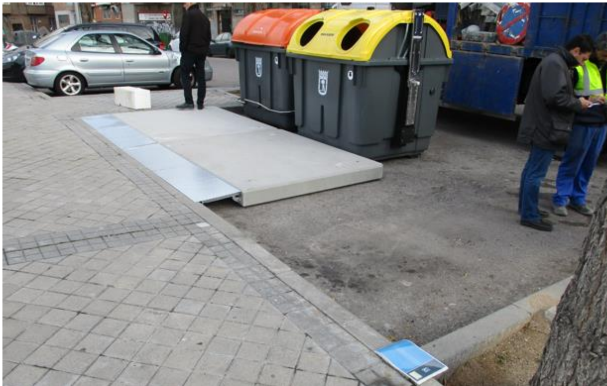
Imagen 13. Instalación de plataformas prefabricadas para facilitar la aproximación de las personas para la utilización de los contenedores de residuos municipales
