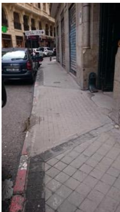
Imagen 2. Vado de vehículos en aceras estrechas en la calle de las Infantas
