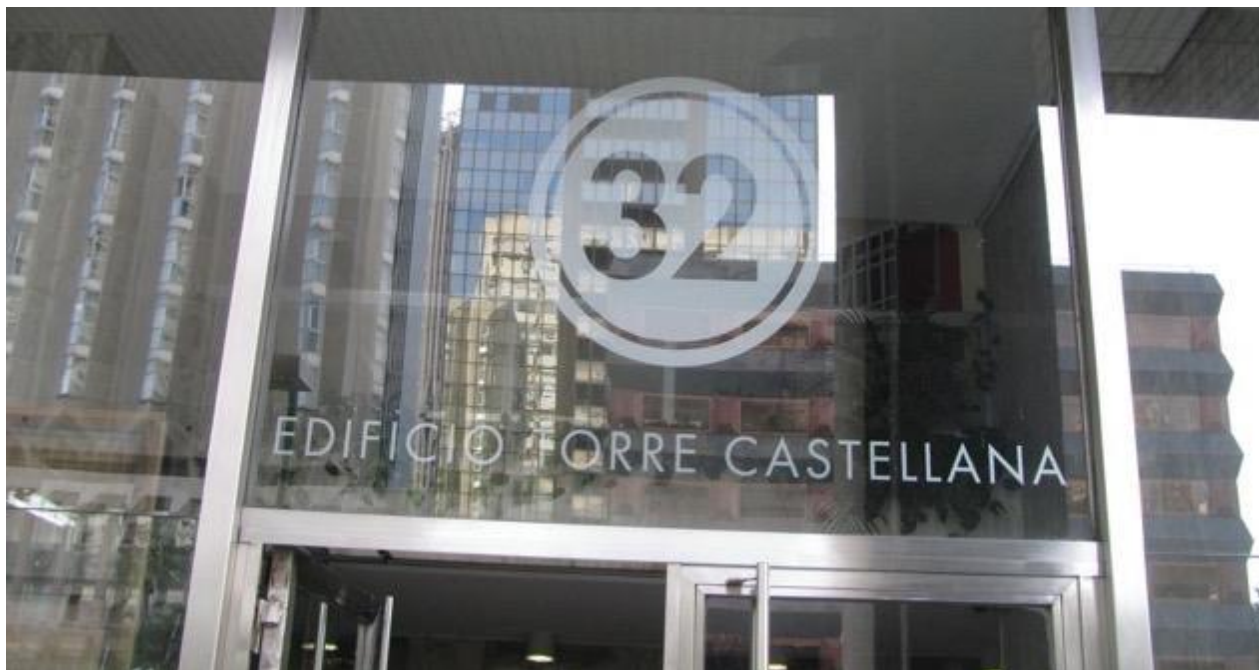
Imagen 5. Nombre de la calle y números en los edificios con un tamaño de letra y ubicación correctos, pero con mal contraste cromático y elección del material al producir deslumbramientos
