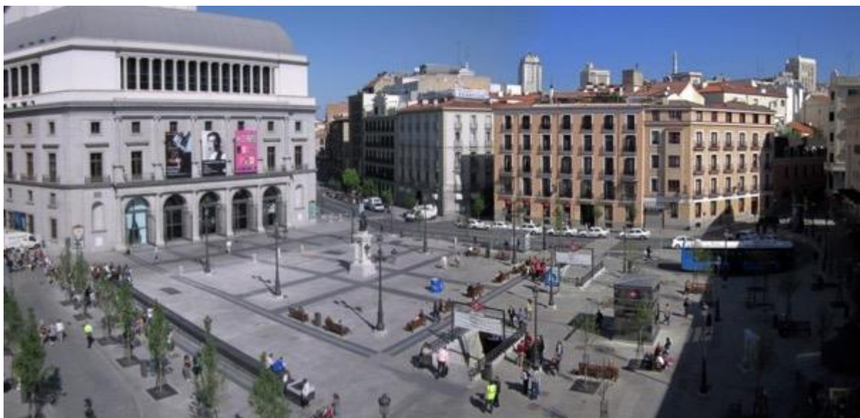
Imagen 1. Vista general de la Plaza de Isabel II, en la que se aprecia el uso de pavimentos tacto-visuales a modo de encaminamientos que permiten la circulación entre los distintos modos de transporte del espacio
