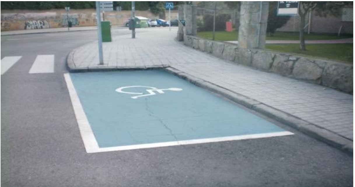
Imagen 7. Mal diseño: plaza reservada de dimensiones insuficientes, sin conexión con el itinerario peatonal y con descenso del conductor sobre el carril de circulación de vehículos
