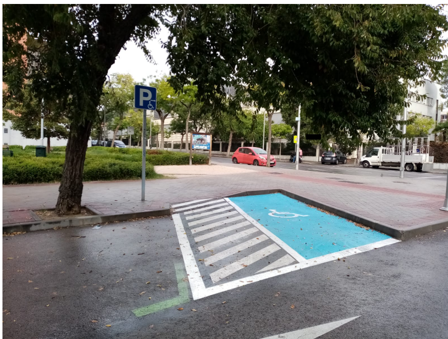
Imagen 5. Detalle de composición de un estacionamiento reservado en la calle Paraguay 9, Madrid. La conexión entre el itinerario peatonal y la franja de transferencia lateral se configura mediante un vado en la acera
