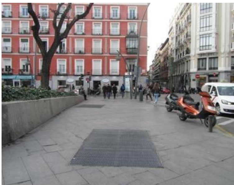
Imagen 7. Detalle de rejilla de gran dimensión en la plaza de Tirso de Molina en el itinerario peatonal, con diámetros de orificio adecuados para el paso seguro de las personas
