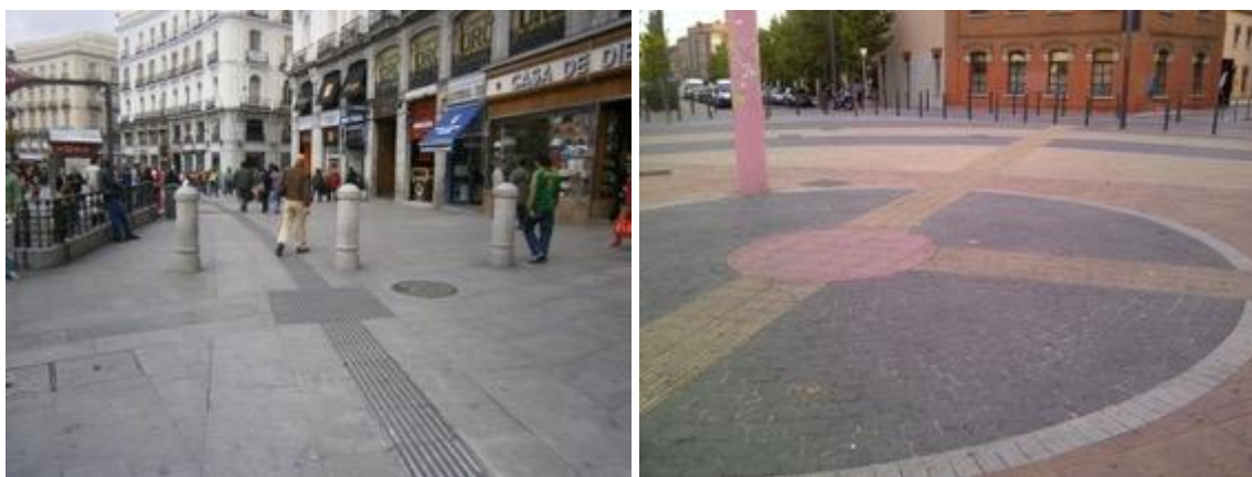
Imagen 8. Uso de encaminamientos mediante baldosas tacto-visuales direccional a modo de guía en los recorridos de un espacio público abierto
