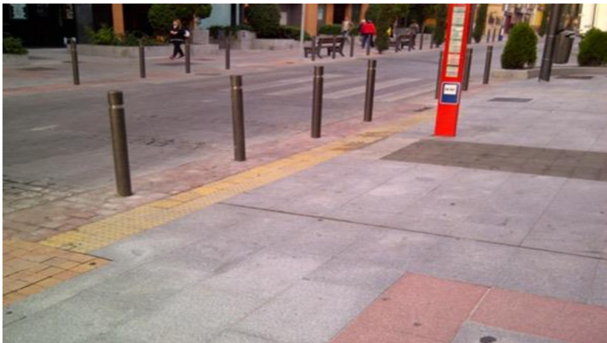
Imagen 6. Disposición de pavimentos tacto visuales en un poste de parada de autobús urbano
