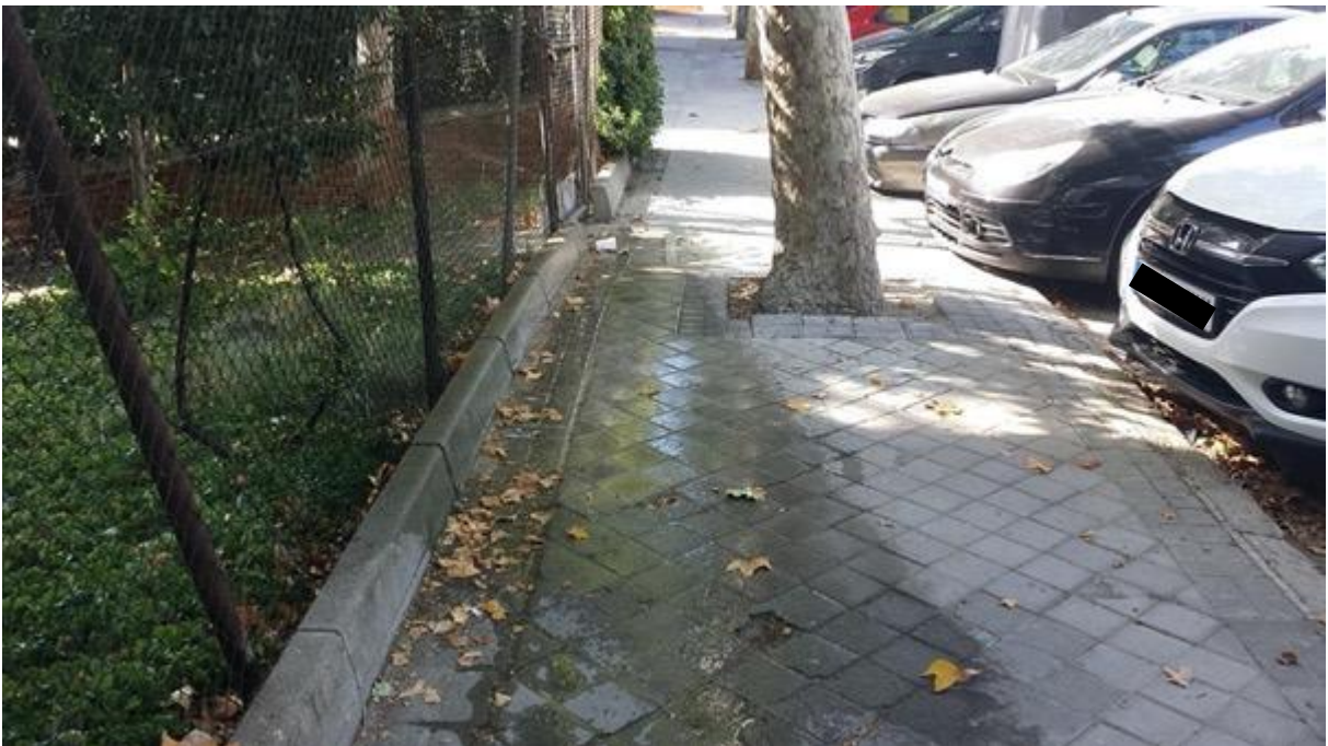
Imagen 17. El riego de las zonas verdes debe realizarse evitando el encharcamiento de las aceras colindantes
