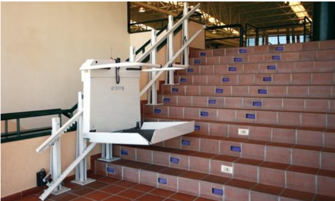
Imagen 3. Plataforma elevadora inclinada (salva escaleras)
