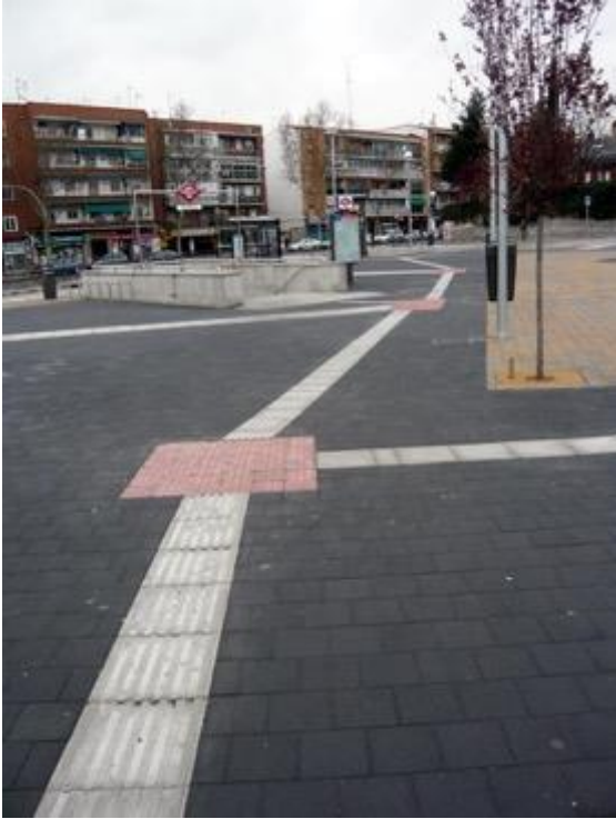
Imagen 21. Encaminamiento direccional con rosetas para indicar el cambio de dirección para transporte público, paso de peatones, etc.
