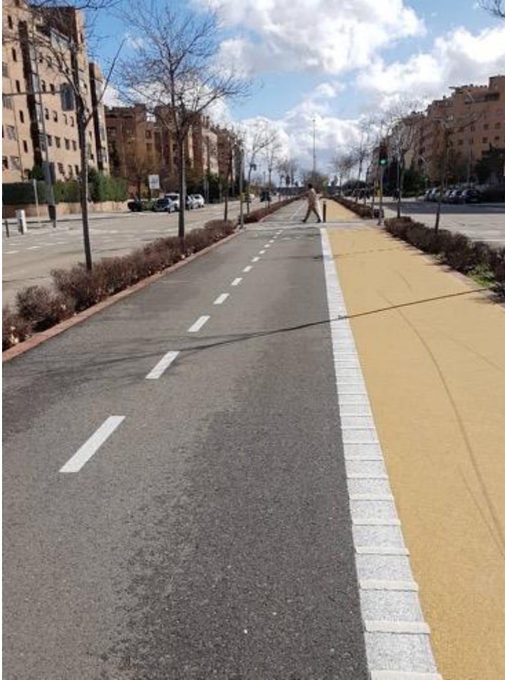
Imagen 11. Flujos segregados mediante señalización horizontal en el Anillo Verde Ciclista
