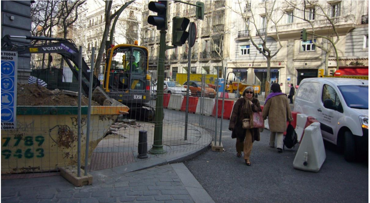
Imagen 7. La prioridad del recorrido alternativo debe quedar claramente marcada y acotada respecto a la calzada
