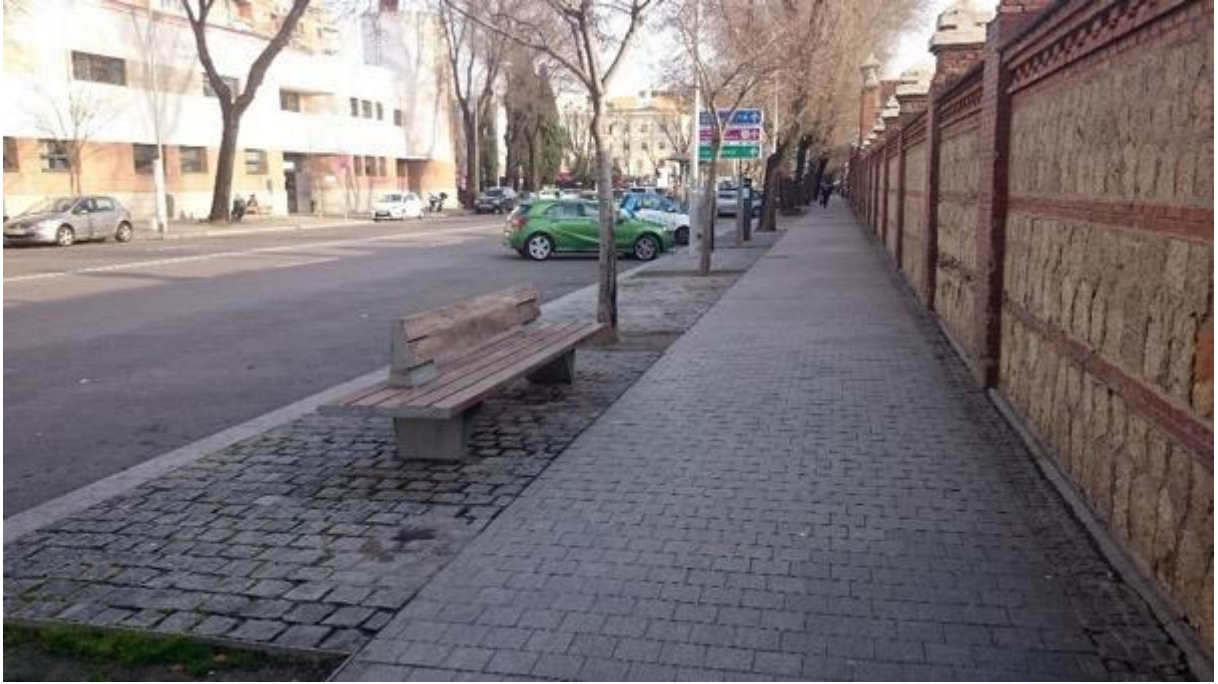
Imagen 11. Paseo de la Chopera. El IPA claramente definido con pavimento diferenciado en textura y color con la banda de colocación de mobiliario
