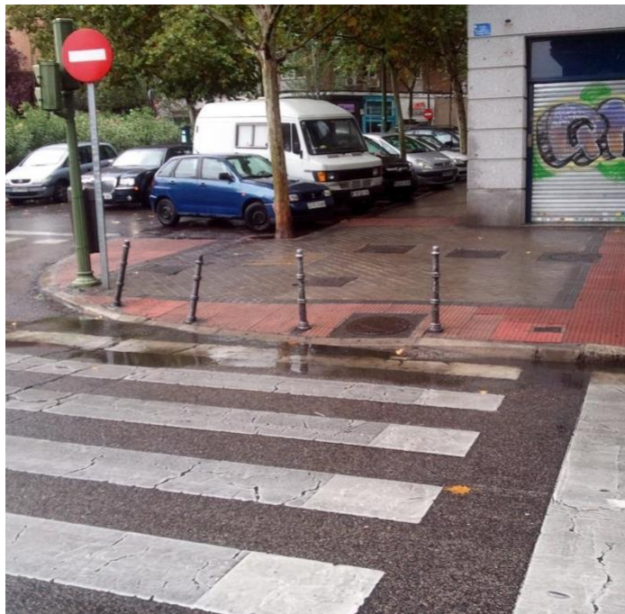
Imagen 10. Estado de conservación de un elemento de drenaje superficial que provoca, en días de lluvia, un encharcamiento en el vado de peatones
