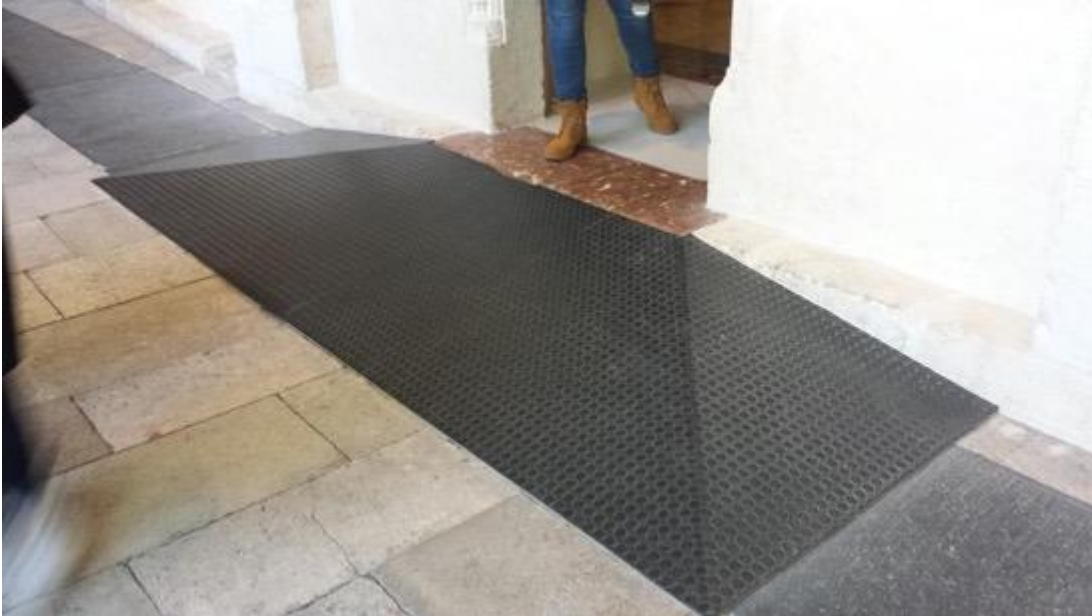
Imagen 12. Rampa temporal de acceso a edificios. En ocasiones el acceso a comercios o locales puede resolverse con elementos temporales en los que el tratamiento del escalón lateral como rampa limita el peligro de tropiezo
