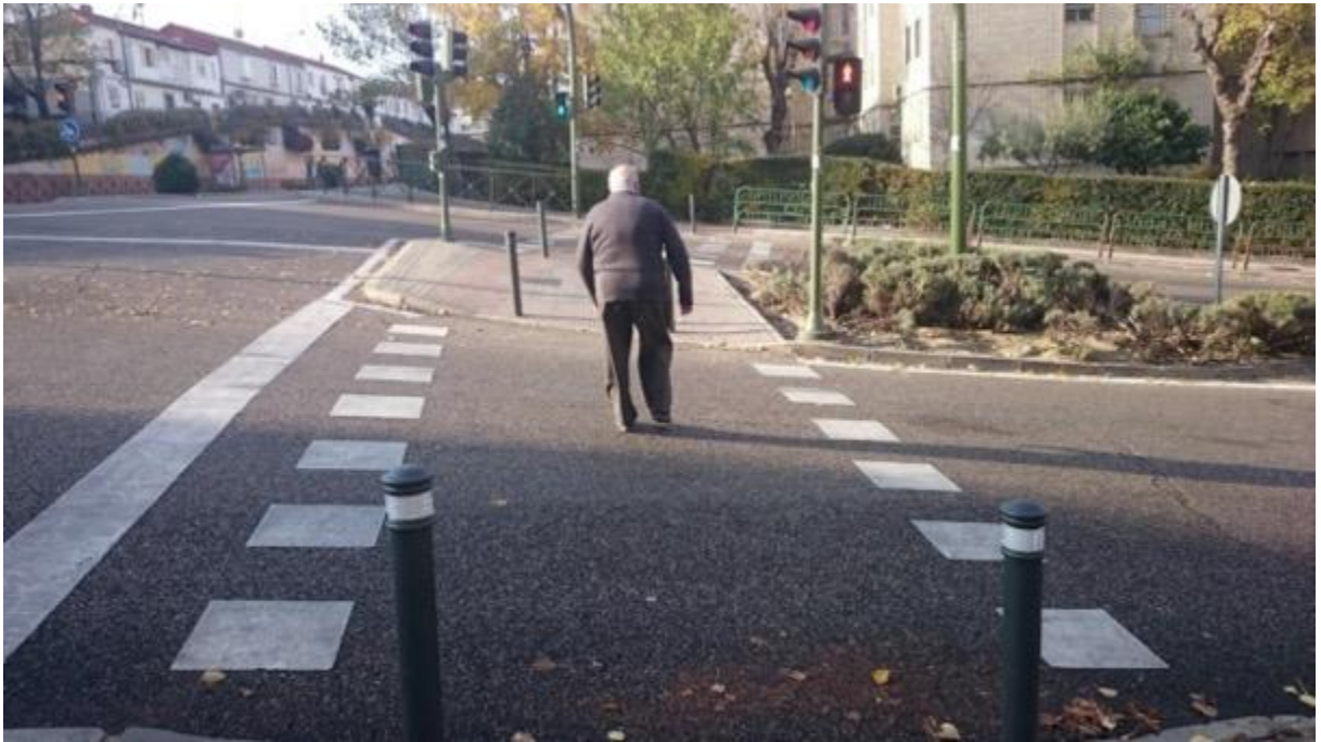
Imagen 28. Paso de peatones con excesiva pendiente transversal en la calle de Cebreros
