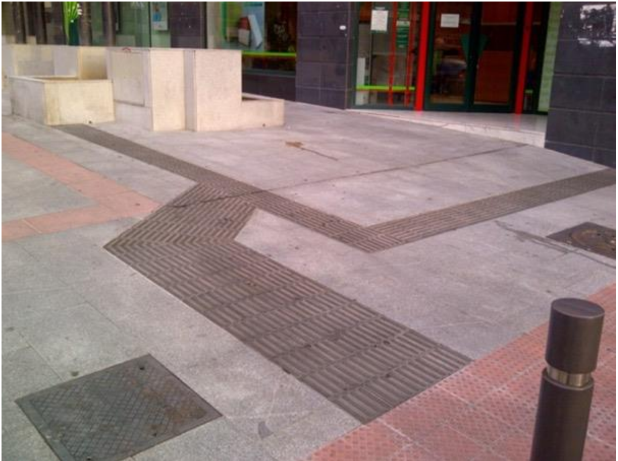
Imagen 12. Uso de pavimentos auxiliares para marcar la "alineación virtual" de fachadas
