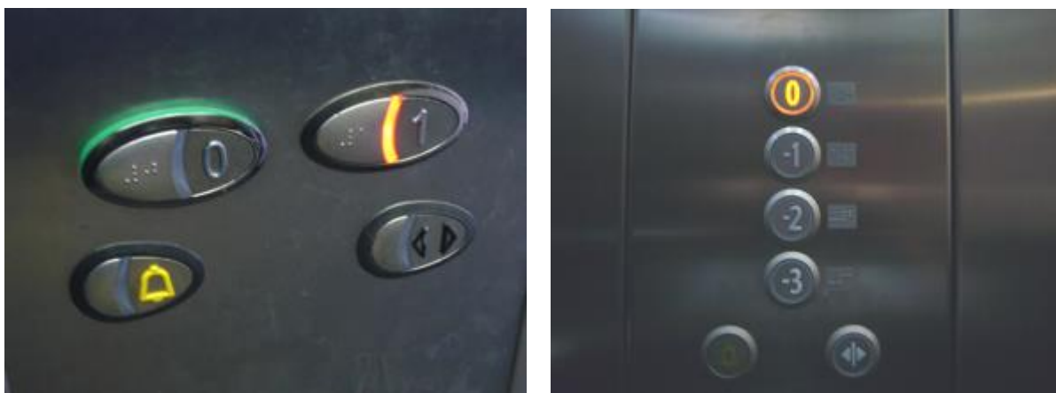
Imagen 8. Botoneras en el interior de la cabina. Deben ser intuitivas y de fácil manejo, con diferenciación de los botones de alarma y apertura de puertas, altorrelieve y Braille en los asignados a plantas. Todos los elementos manipulables deben estar a una altura adecuada
