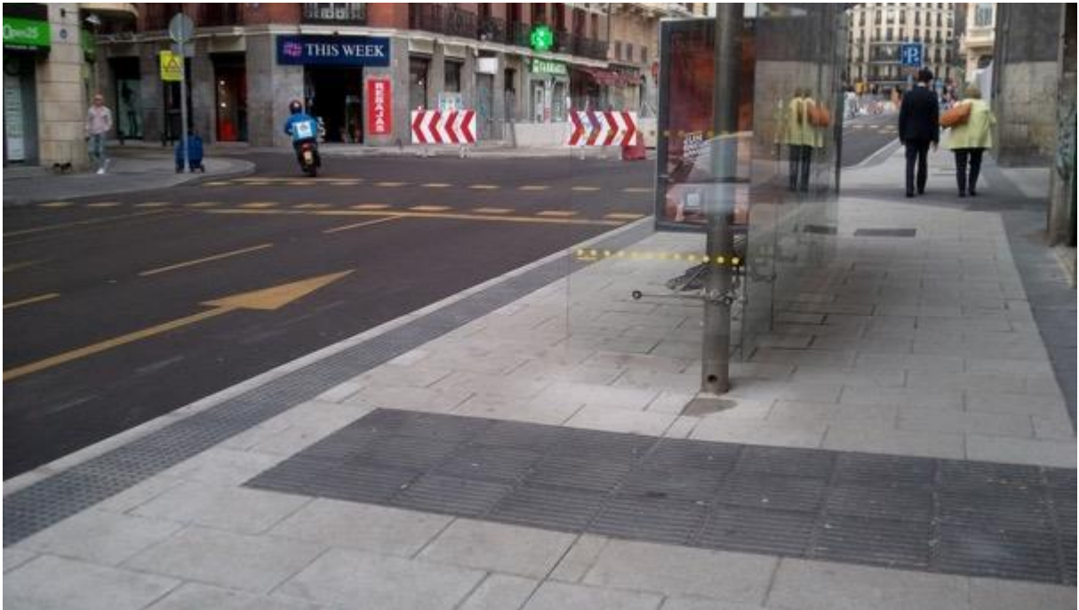
Imagen 11. Uso de pavimentos tacto visuales en la señalización de una marquesina de autobús urbano
