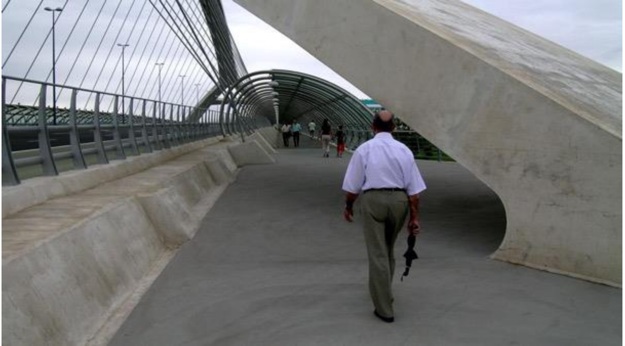
Imagen 4. Puente del Tercer Milenio en Zaragoza. Las reducciones de gálibo en el itinerario peatonal deben evitarse o, en su caso, señalizarse adecuadamente
