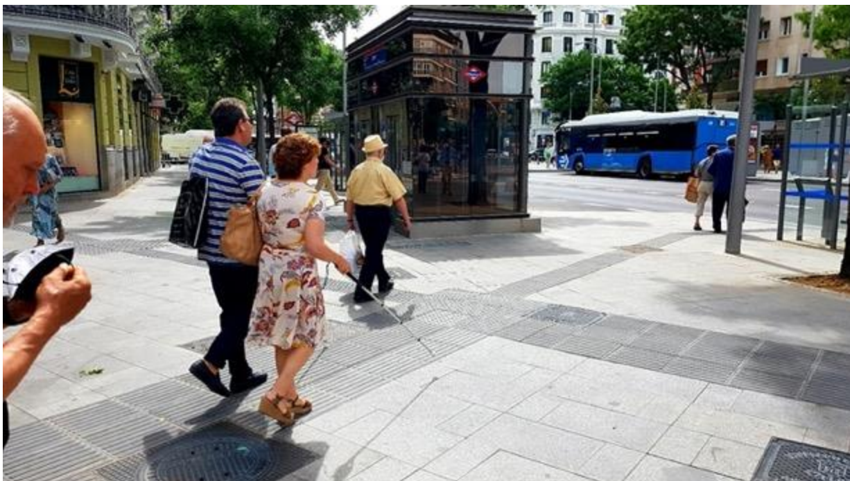
Imagen 4. Detalles de encaminamiento en la calle de Alcalá donde pueden apreciarse las líneas y "rosetas"
