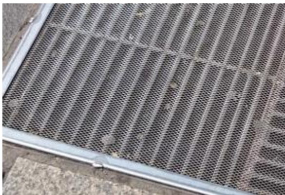
Imagen 8. Adaptaciones de rejillas existente a los criterios de accesibilidad, en las calles de Barceló y Santa Hortensia
