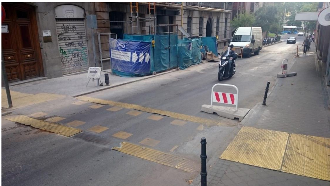
Imagen 11. Desvíos provisionales del itinerario peatonal con paso de peatones provisional
