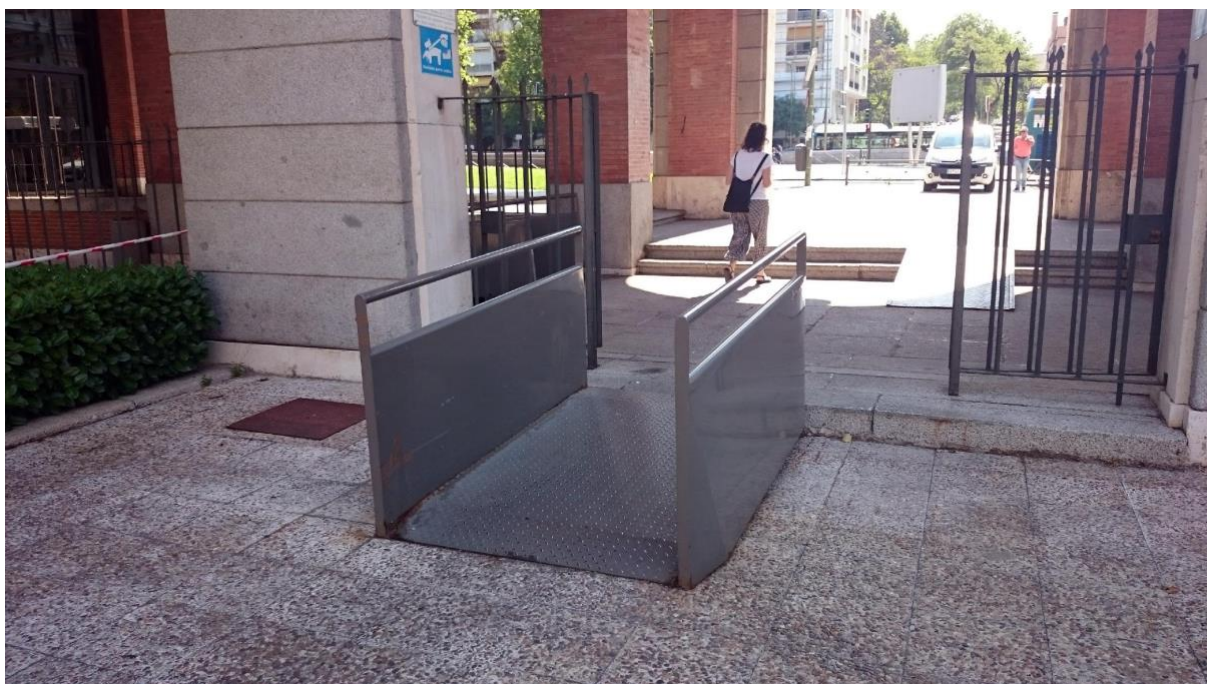
Imagen 1. Rampa removible en los Nuevos Ministerios
