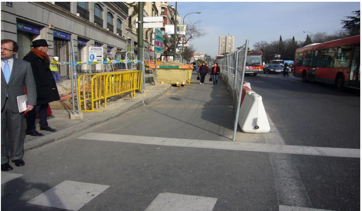
Imagen 1. Protección de itinerario alternativo por obras en vía pública. Se observa que no se ha resuelto adecuadamente el escalón producido en la conexión entre el itinerario peatonal existente y el provisional
