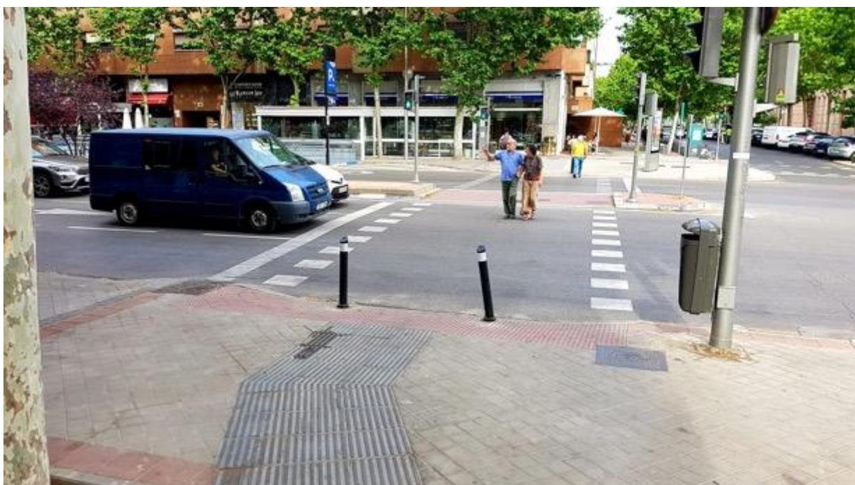
Imagen 18. Bandas de dirección y detección no alineadas
