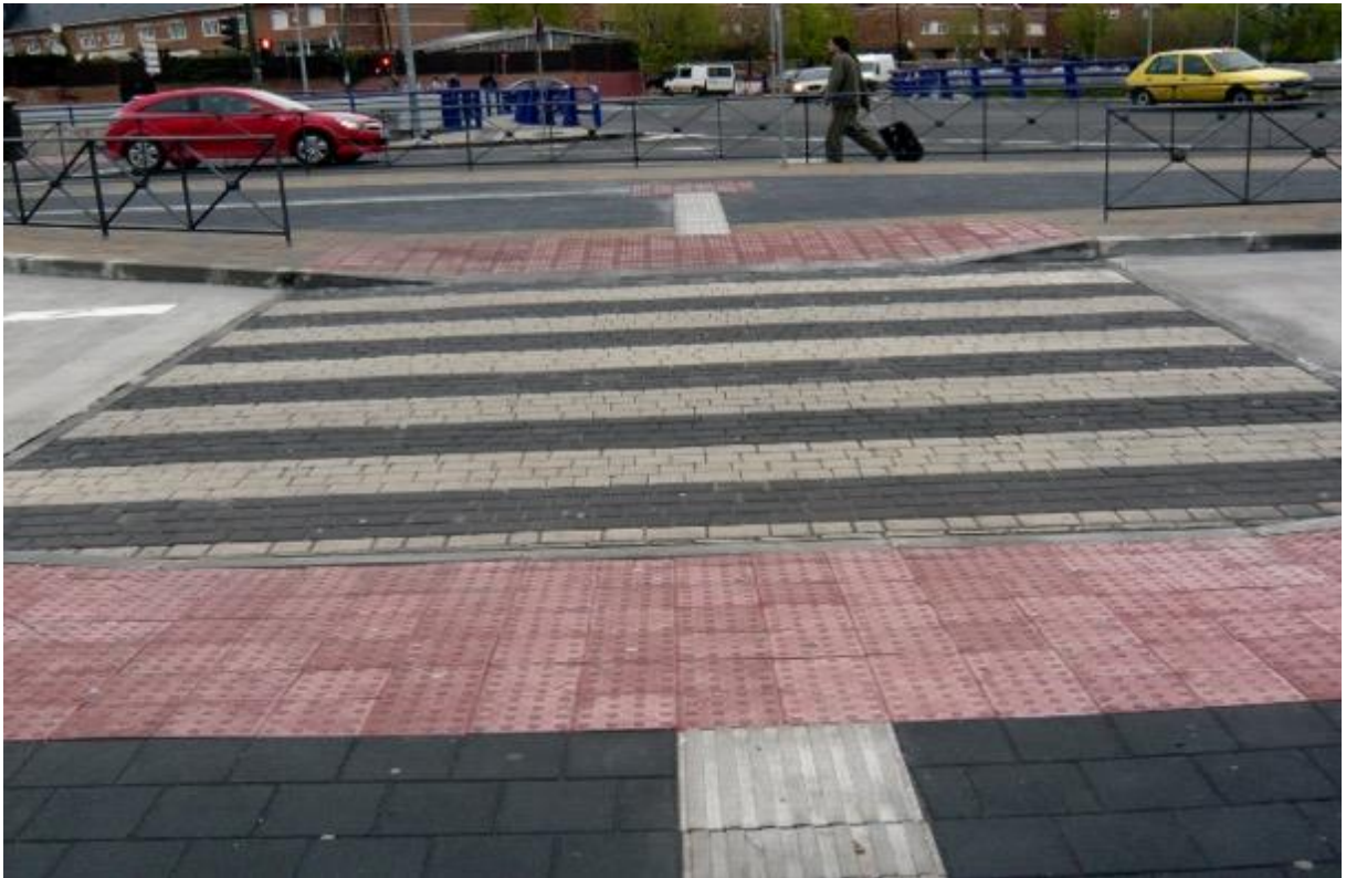
Imagen 19. Área intermodal de Canillejas. Al tratarse de un área intermodal en la que se establecen pavimentos en bandas de encaminamiento entre distintas áreas, las bandas de detección y dirección son sustituidas por los mencionados encaminamientos
