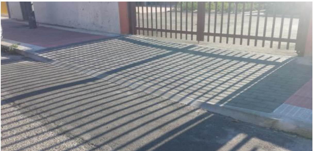
Imagen 8. Formación de un vado de vehículos en acera estrecha con cambio de pavimento
