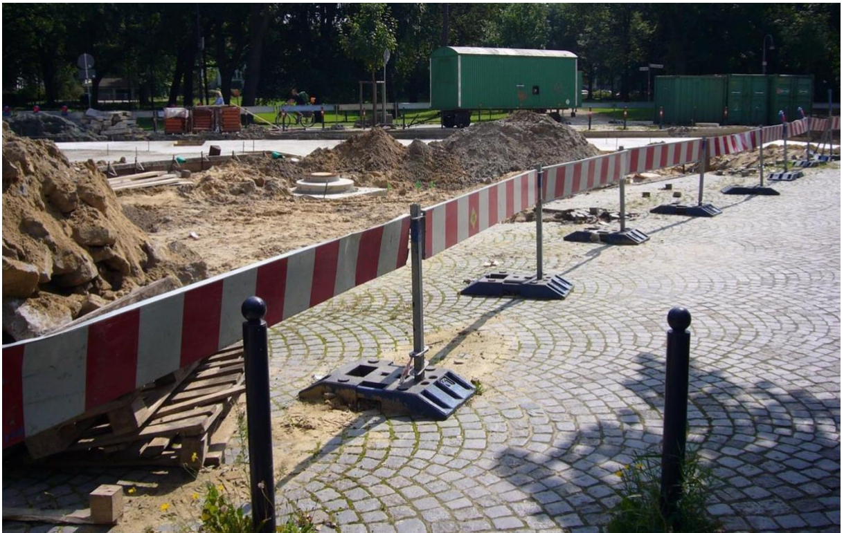
Imagen 2. Protección de zona de obras mediante vallado provisional. Los soportes de las vallas parecen sólidos; sin embargo, el hueco permite el acceso de un niño a la zona de obra
