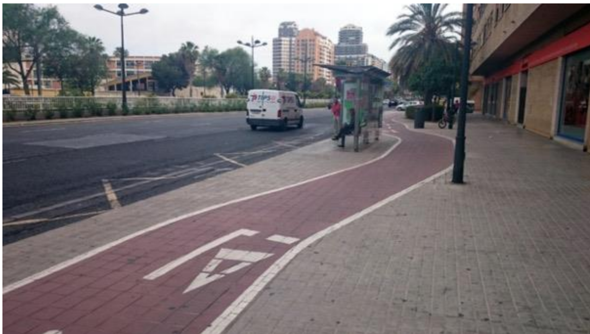
Imagen 16. Acera-bici en Valencia situada por detrás de la marquesina de la parada de autobús
