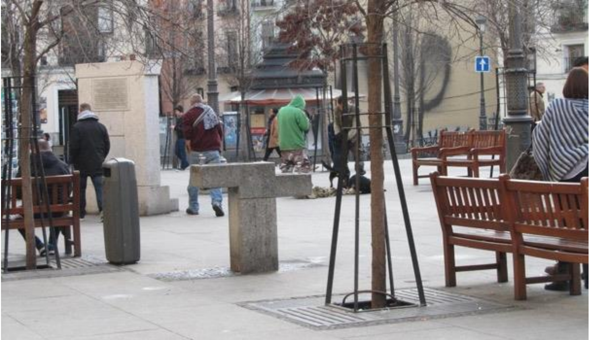
Imagen 15. Alcorques ubicados dentro del itinerario peatonal con el modelo anterior de rejilla de la imagen 16
