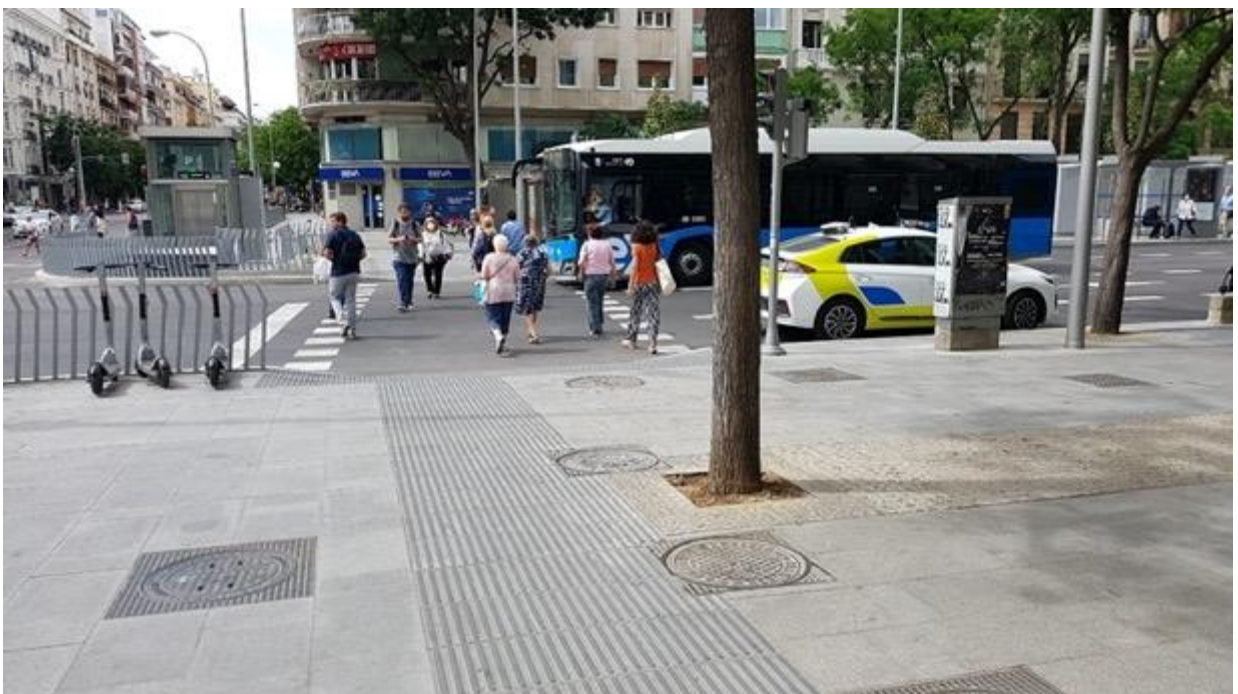
Imagen 24. Posición de la banda de dirección en la calle de Narváez. Si bien la posición óptima de la banda de dirección se corresponde con el eje central del paso de peatones, en ocasiones, tal como se muestra en la imagen, la banda de dirección del vado de peatones puede sufrir un desplazamiento lateral a fin de evitar algún posible obstáculo (mobiliario urbano, arbolado, etc.), conservando siempre la posición más próxima al eje central
