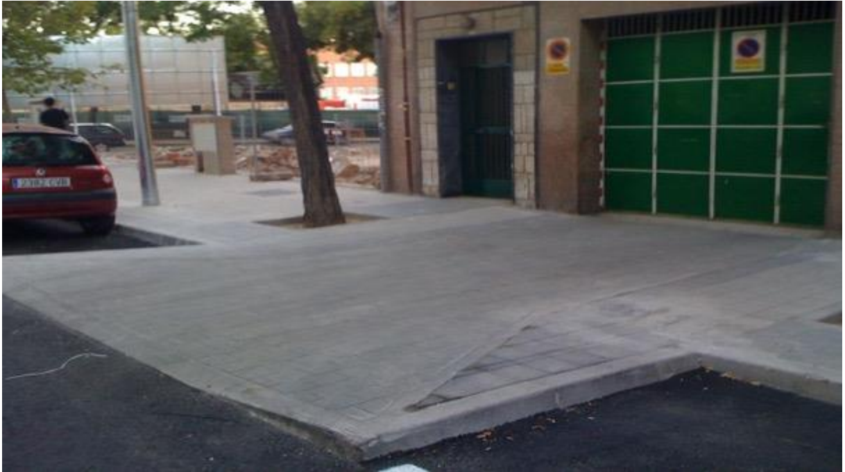
Imagen 7. Vado formado por bordillos tipos IX y X de la NECOU, en zona de aparcamiento
