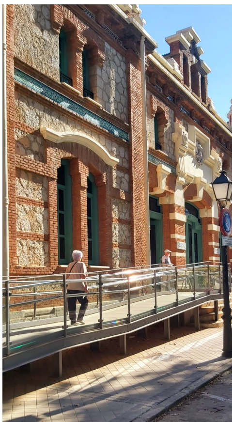
Imagen 3. Junta Municipal de Arganzuela, Madrid. Rampa junto a edificio protegido sin afectar su naturaleza constructiva
