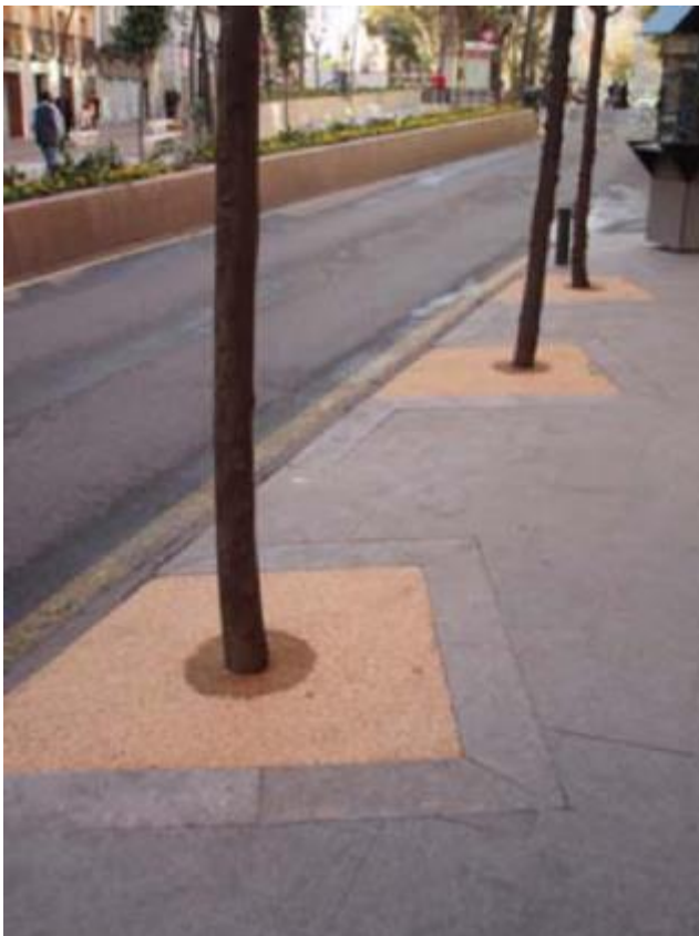
Imagen 25. Diseño de alcorque enrasado con el pavimento
