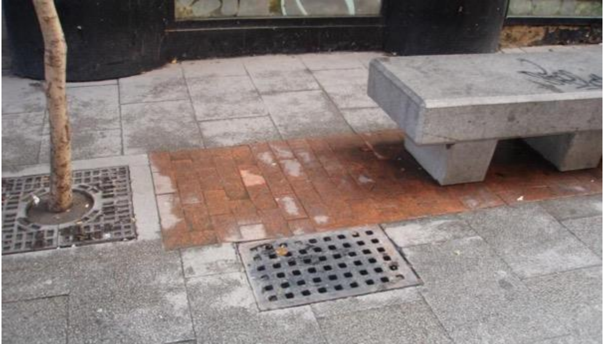
Imagen 13. Detalle de rejilla ubicada contigua a la banda de mobiliario dentro del itinerario peatonal accesible
