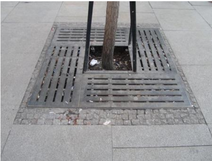
Imagen 16. Detalle de alcorque enrasado con pavimento a través de una rejilla metálica
