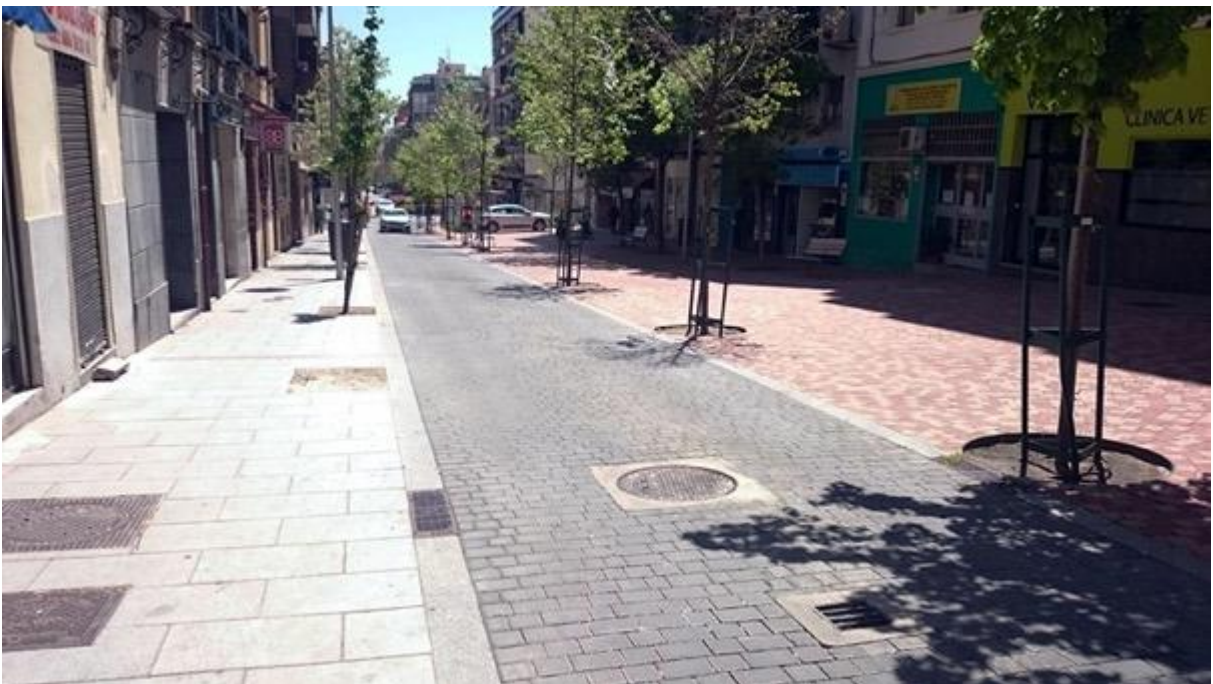
Imagen 10. Pavimentos en itinerario peatonal accesible en una calle de plataforma única en la calle del Pilar de Zaragoza. La zona de uso exclusivo de peatones se delimita de la zona compartida con el paso de vehículos a través del contraste cromático y de textura de los pavimentos
