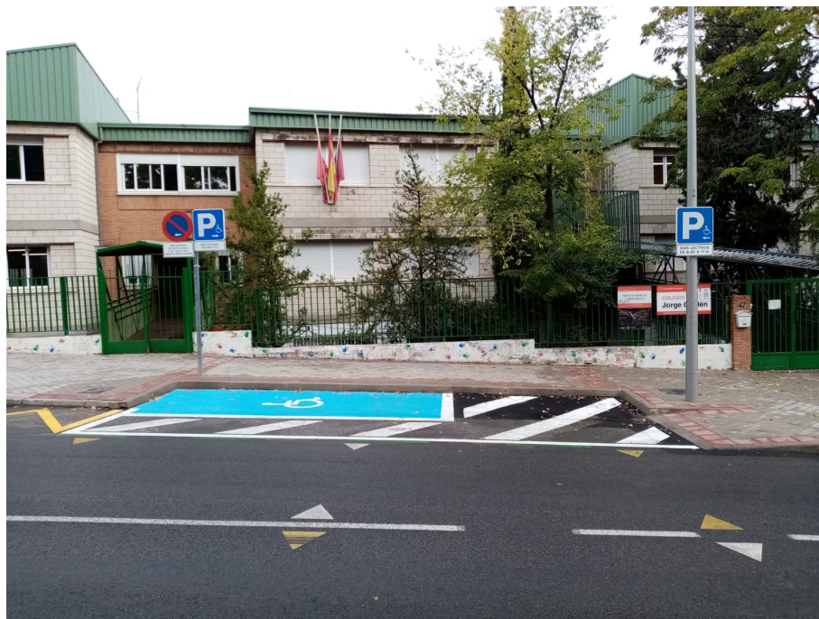
Imagen 10. Plazas en línea en Avenida de Ferrol, Madrid. Con zona de transferencia lateral y trasera y vado en acera
