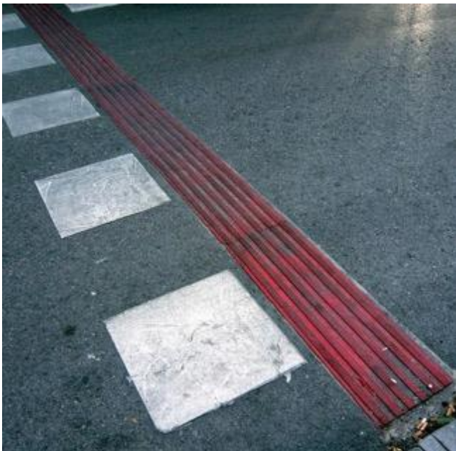
Imagen 29. Relieve en calzada en el borde del paso de peatones en la calle de Bárbara de Braganza
