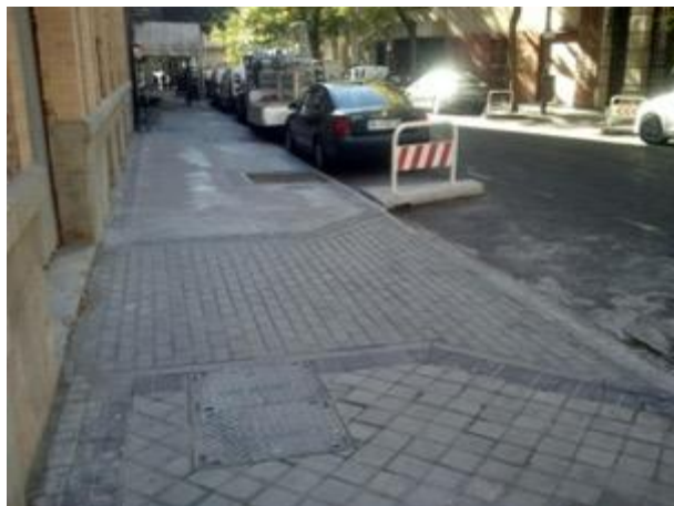
Imágenes 3 y 4. Vados de vehículos con pavimentos de aspecto peatonal. En la imagen 4 se aprecian elementos prefabricados para interrumpir la banda de estacionamiento
