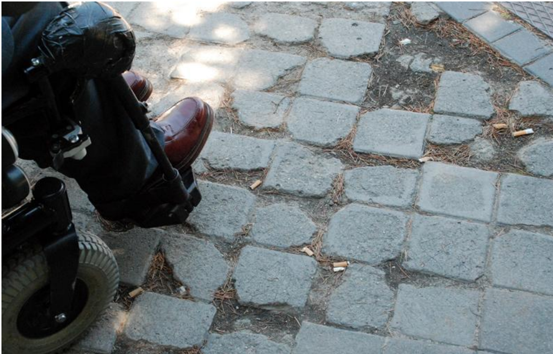
Imagen 1. La falta de mantenimiento y reposición del pavimento afecta a sus condiciones de accesibilidad, favoreciendo tropiezos y dificultando el tránsito de usuarios de sillas de ruedas
