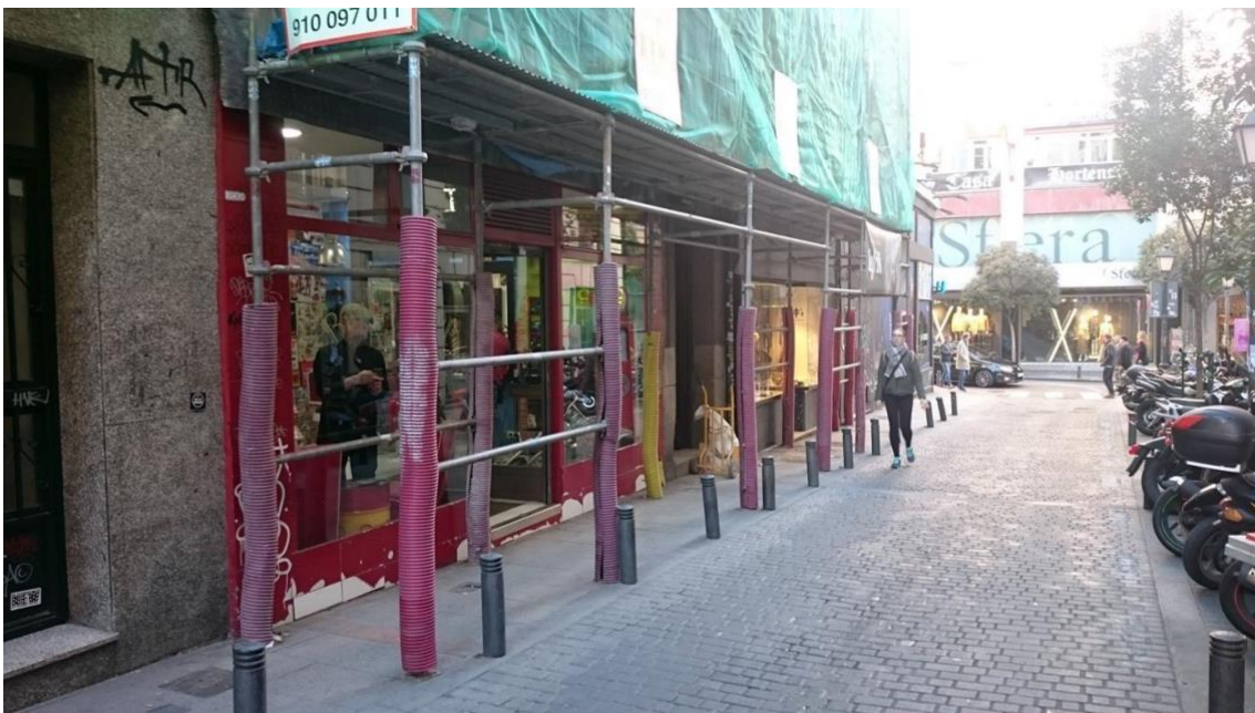
Imagen 4. Protección de andamios en la vía pública
