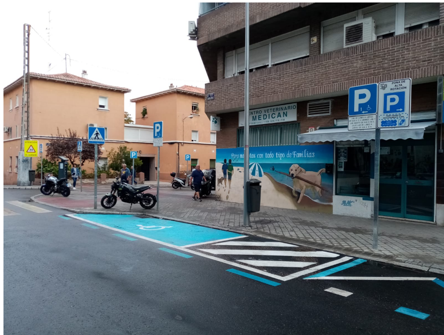
Imagen 9. Plaza en línea en calle Aguiléñas, Madrid. Con zona de transferencia trasera y paso a través del colindante paso de peatones
