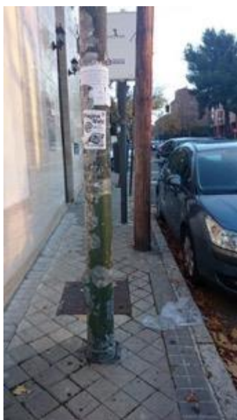
Imagen 2. Acera en la calle del Duque de Tamames. En la que se puede observar la proliferación de elementos de mobiliario urbano en el itinerario peatonal accesible, llegando no sólo a invadirlo sino a impedir la deambulación por el mismo
