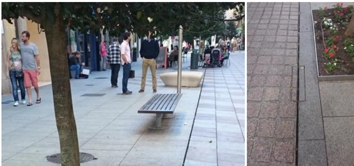
Imagen 23. Ejemplos de sistema de drenaje superficial utilizando las juntas en el pavimento en Santander
