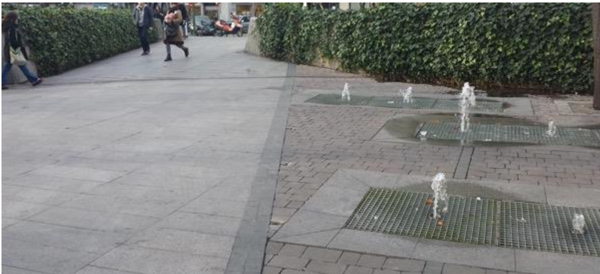
Imagen 6. Lámina de agua y fuente protegida con rejilla y pavimento perimetral diferenciado, situada en la Plaza de Tirso de Molina
