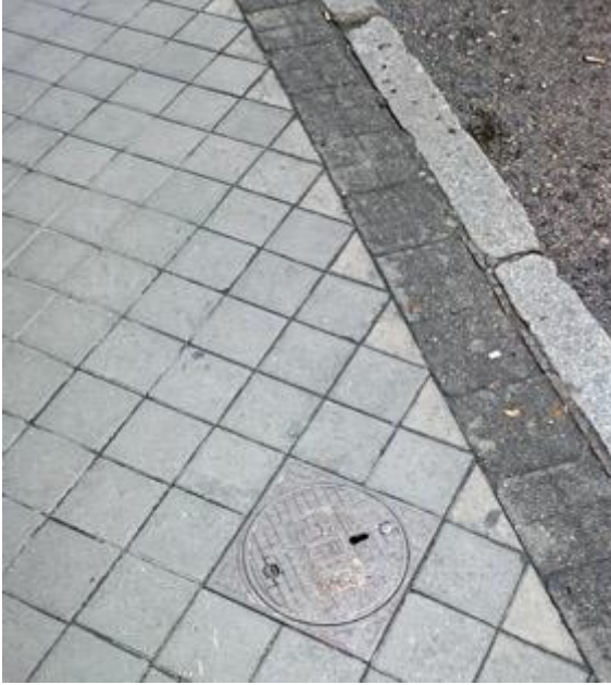
Imagen 10. Correcta colocación de una tapa de registro. La tapa está expresamente diseñada para facilitar su enrasamiento con el pavimento y para no precisar cortes en las piezas de pavimentación más habituales en el municipio de Madrid
