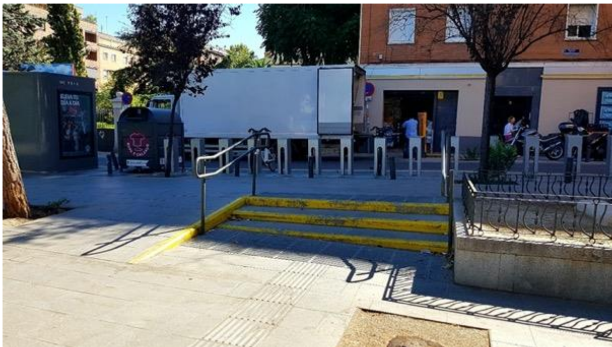
Imagen 13. Escalones de geometría irregular en la plaza de Prosperidad
