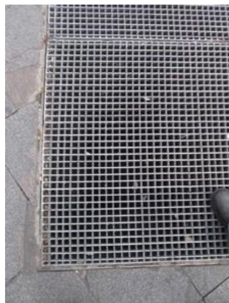
Imagen 7. Detalle de rejilla de gran dimensión en la plaza de Tirso de Molina en el itinerario peatonal, con diámetros de orificio adecuados para el paso seguro de las personas
