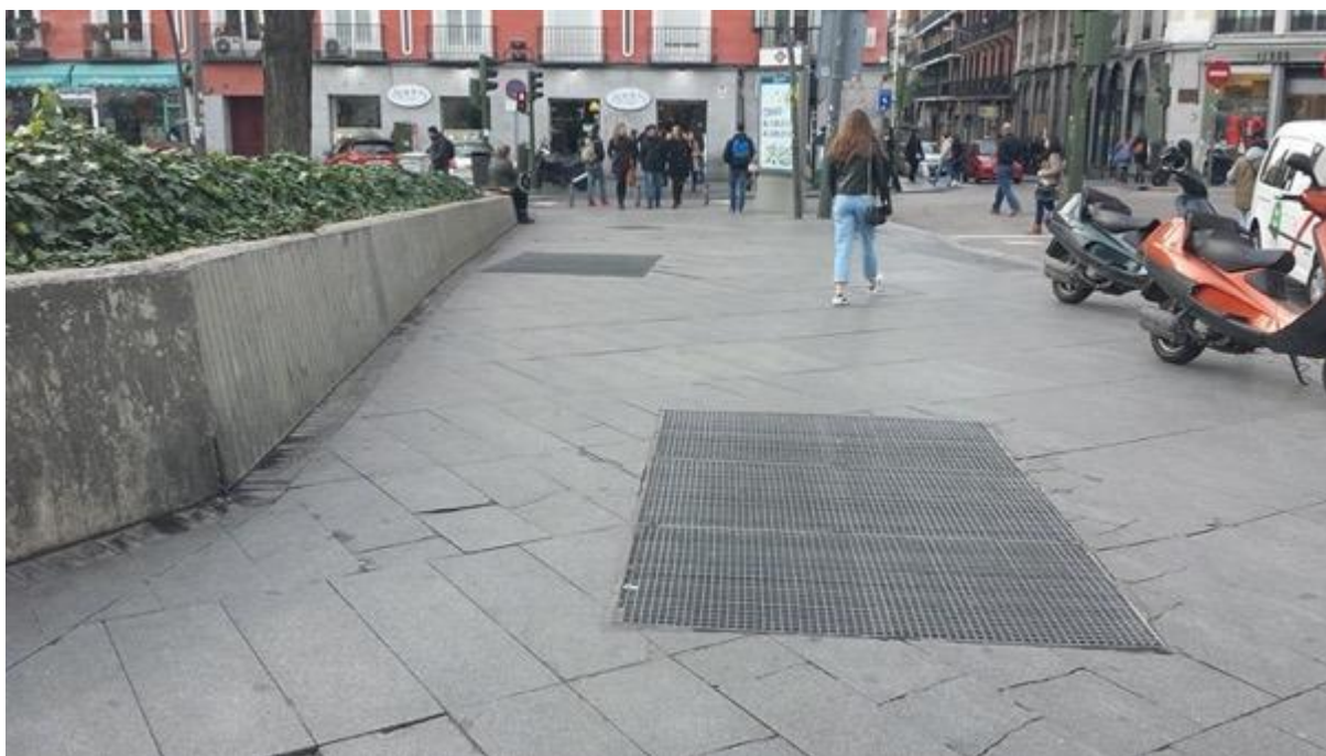
Imagen 13. Rejilla de ventilación de Metro en la plaza de Tirso de Molina. Es habitual que en plazas de cierto tamaño se dispongan rejillas en los recorridos accesibles, que por lo tanto deberán garantizar una trama de no más de 1,6 cm de apertura
