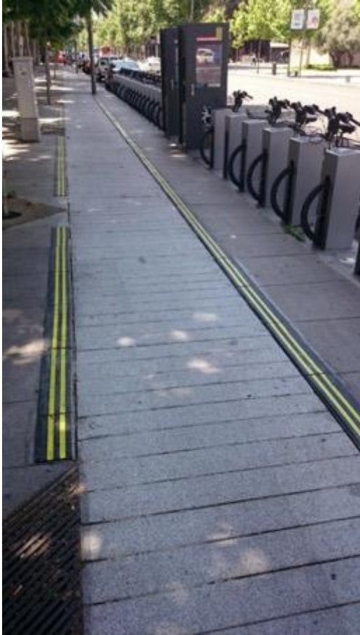
Imagen 9. Acera-bici en la calle de Serrano con elemento separador del itinerario peatonal dotado de relieve y contraste cromático
