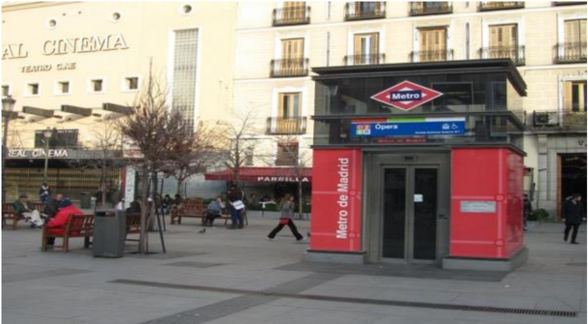
Imagen 7. Señalización con pavimento tacto-visual del acceso mediante ascensor al Metro en la Plaza de Isabel II de Madrid
