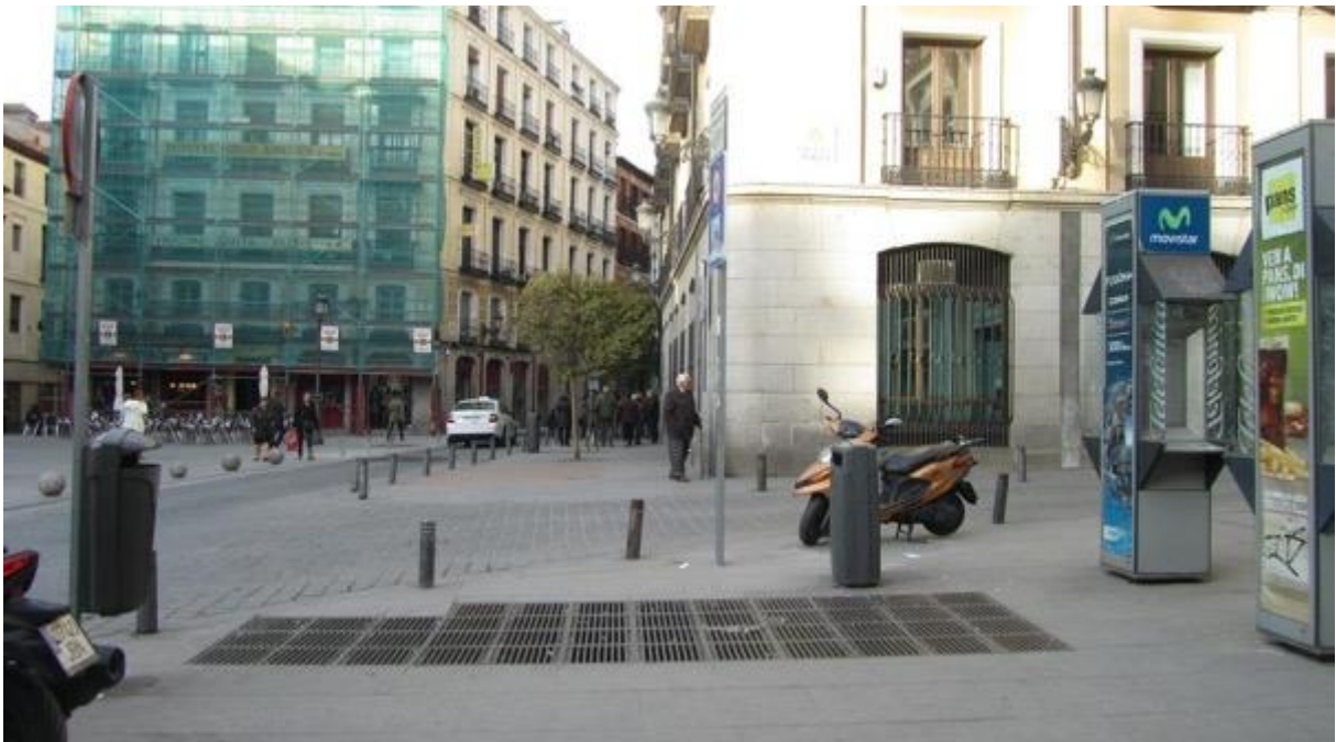
Imagen 11. Detalle de rejilla de gran dimensión en itinerario peatonal accesible
