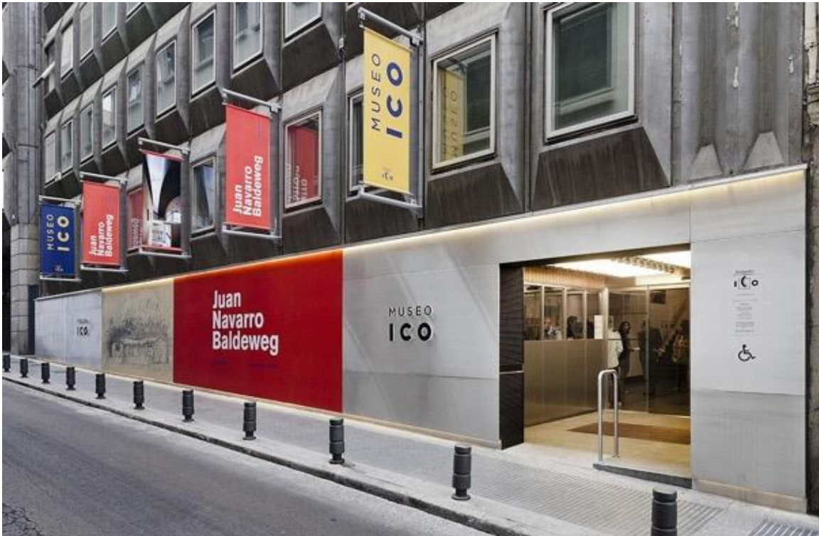
Imagen 8. Fachadas “reconocibles” en la calle de Zorrilla
