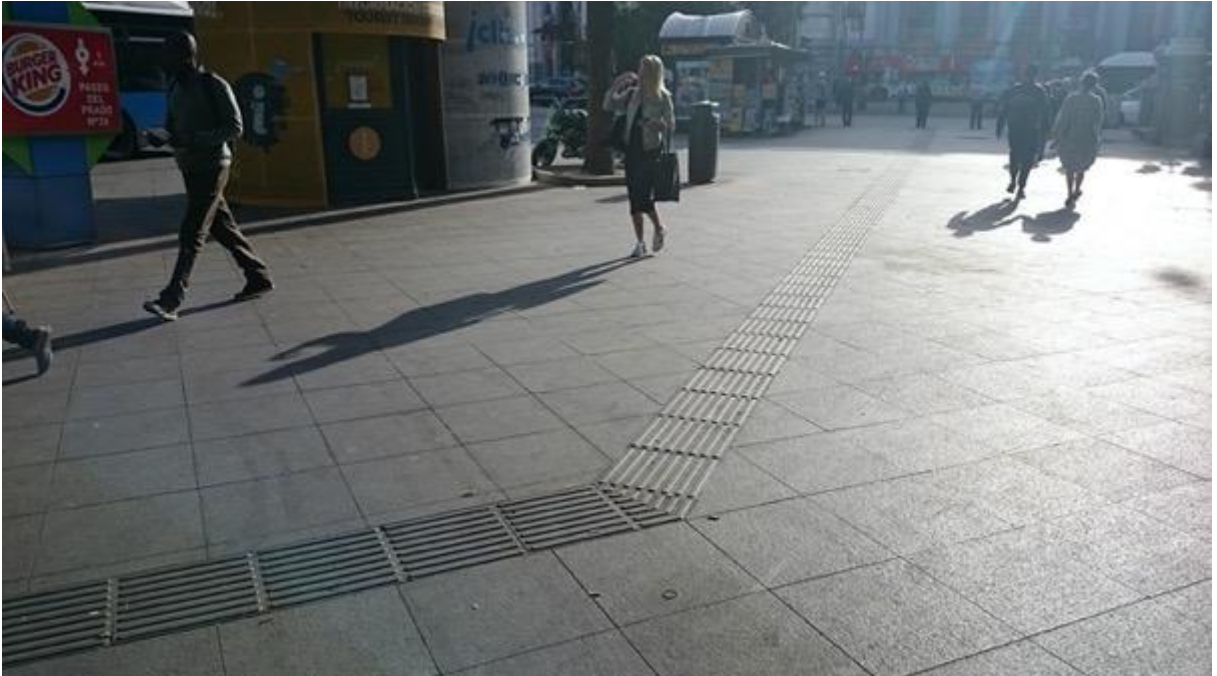
Imagen 20. Detalles de encaminamiento con cambio de dirección en la Plaza de Cibeles
