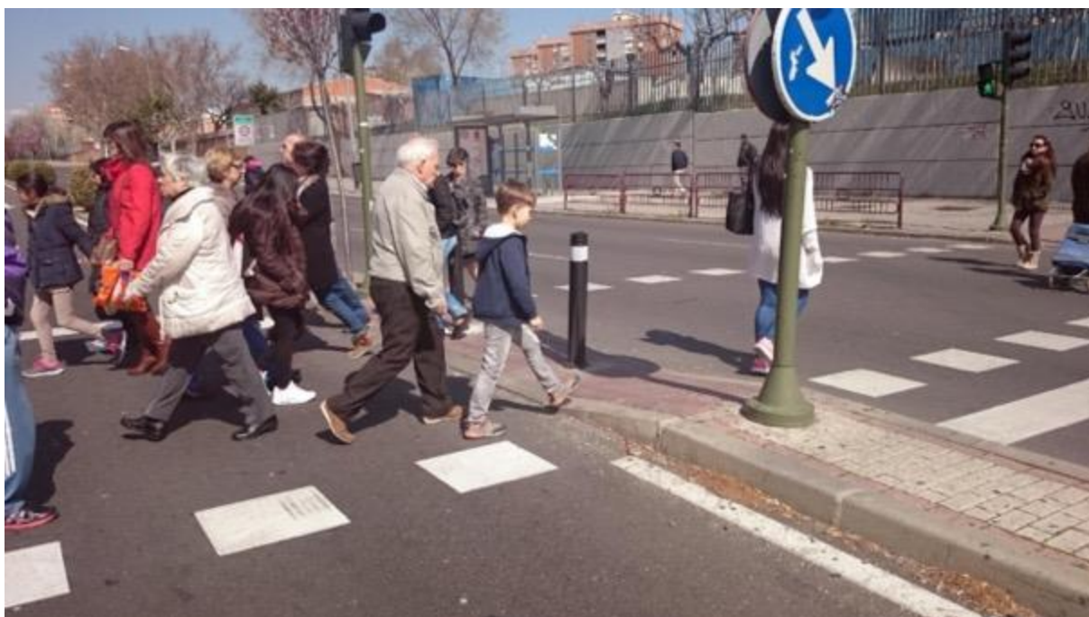
Imagen 27. Isleta de dimensiones claramente insuficientes, en un cruce de alta afluencia peatonal, en la avenida de los Poblados
