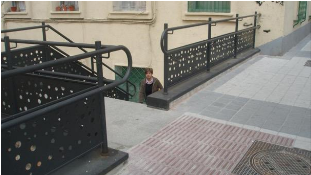
Imagen 11. En la imagen puede observarse la disposición de un rellano previo a la escalera para evitar su inicio desde la alineación de la acera. Sin embargo, el pavimento táctil visual se dispone en la acera para que se detectada desde el itinerario peatonal en la calle de Marcelino Álvarez
