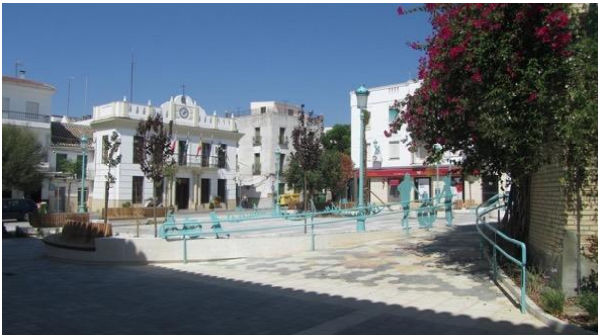
Imagen 3. Resolución de desniveles mediante el uso de rampa, acompañada de barandilla y de un diseño que permite hacerla atractiva a todos los usuarios, junto a escalera integrada en un mismo ambiente arquitectónico. Destaca el empleo de pavimentos tacto-visuales y contraste cromático con el entorno inmediato
