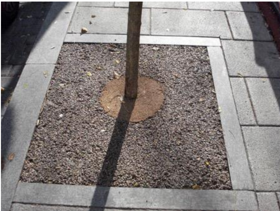
Imagen 14. Ejemplo de alcorque enrasado con el pavimento en Plaza de Callao
