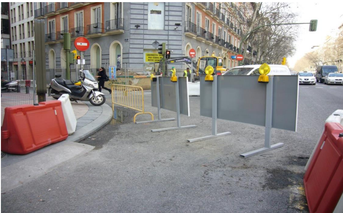
Imagen 5. Balizamiento luminoso en vallado provisional. La falta de unión entre los elementos (vallas, paneles direccionales, etc.) los hacen susceptibles de ser desplazados o volcados por la acción del viento o la manipulación de terceros
