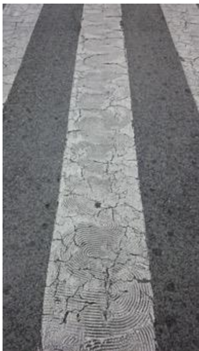
Imagen 26. Relieve superficial en la pintura termoplástica en frío de dos componentes, realizado durante su aplicación, para mejorar las condiciones de no resbaladidad en mojado (Santander)
